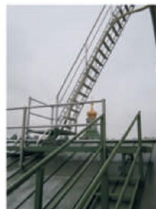
ЛЕСТНИЦЫ ДЛЯ ПЕРЕМЕЩЕНИЯ ПО КРЫШАМ РАЗНОГО УРОВНЯ
