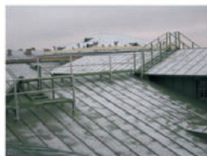
ЛЕСТНИЦЫ, УСТАНОВЛЕННЫЕ НА КРОВЛЕ (КРЫШЕ)
