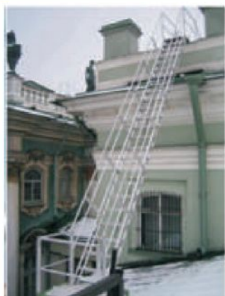
ЛЕСТНИЦЫ ДЛЯ ПЕРЕМЕЩЕНИЯ ПО КРЫШАМ РАЗНОГО УРОВНЯ
