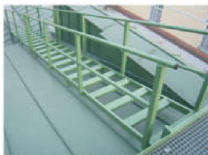
ЛЕСТНИЦЫ, УСТАНОВЛЕННЫЕ НА КРОВЛЕ (КРЫШЕ)
